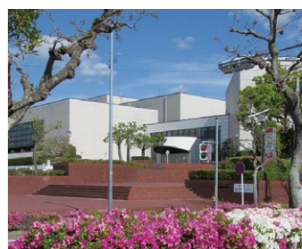
A 岡崎市総合学習センター 1983年に愛知県岡崎労働福祉会館として開館。2010年に閉館し翌年から総合学習センターとして活用
