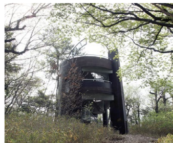
D 大谷公園展望台 公園内に古窯跡があることから勾玉の形の丘を造成し、「過去・未来を見据える展望台」として銅鐸をモチーフに建設
