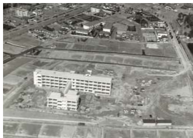
上地小学校工事中 (1983)
