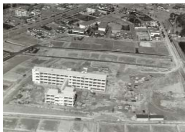
上地小学校工事中
