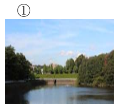
① 若松町の灌漑用ため池とし整備され、上地の土地区画整理事業で3分の1が埋め立てられた奥山田池
