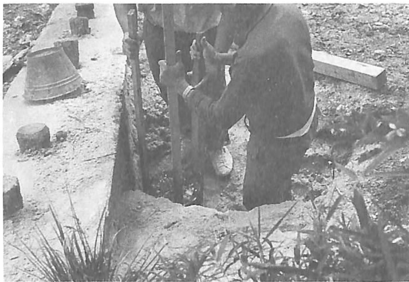
大谷池の用水栓と水漏れ箇所修理作業(加藤又治郎さん提供)
