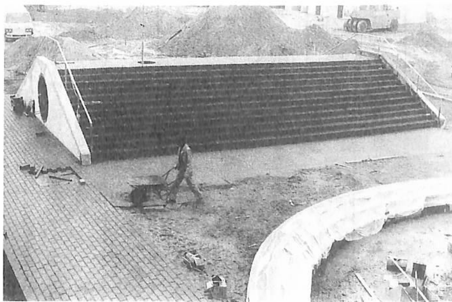
工事中のサンクガーデン
