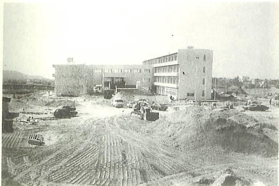
急ピッチに進む運動場工事（昭和58年2月）
