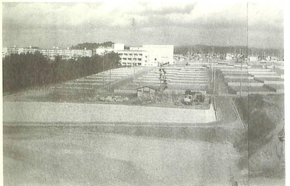
上地小学校建設工事前の校地（昭和47年度）
