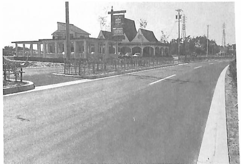
地下道と4車線化の完成（同上）昭和55年
