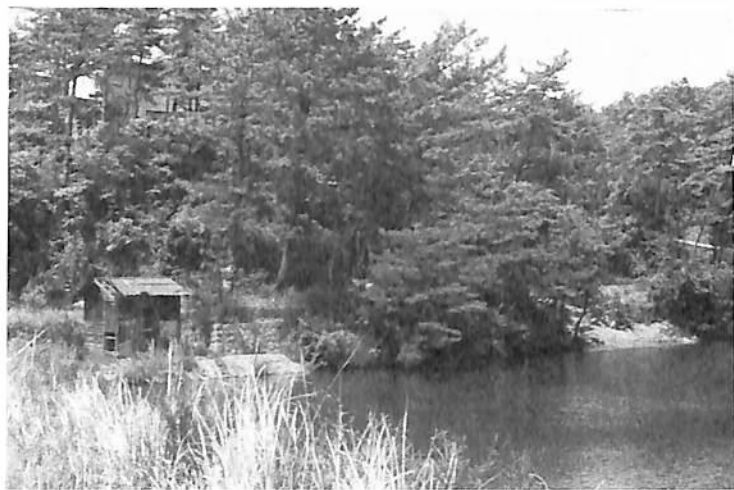
改修工事前の奥山田池（柴田 勝氏提供）
