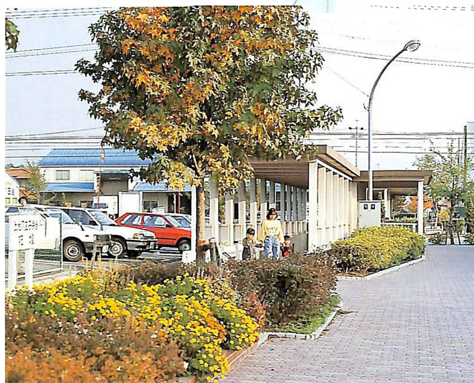
幹線道路を横切る地下道。子供達にも安全教育が徹底して行われており、これからの住宅団地造成の手本にもなっている。
