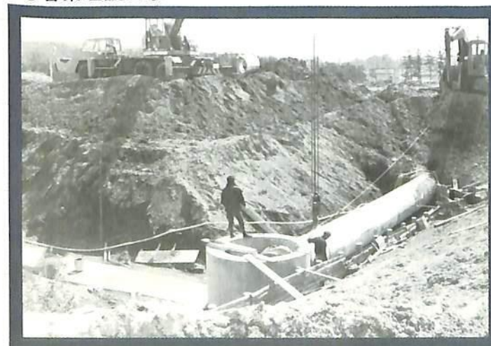
●管渠埋設工事
